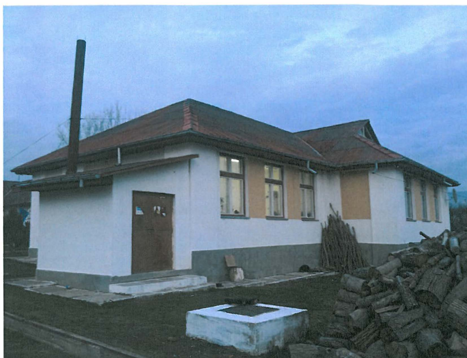
Clădire Școală – imagine exterioară (existent)
